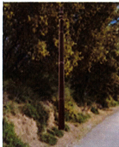
Photo d'ensemble de l'emplacement avec implantation soufletée
